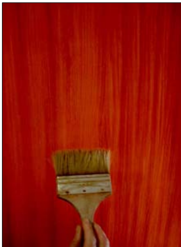
Photo 2 : Lissez avec le spalter
