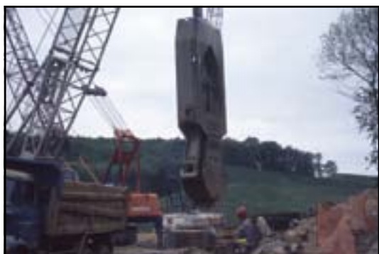
Illustrations 90 et 91 : Parois moulées avec benne suspendue à un câble
