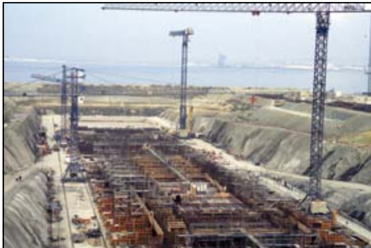
Illustration 108 : Réalisation d'un quai en cale sèche
