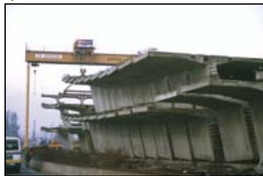
Illustrations 61 et 62 : Stockage des voussoirs préfabriqués
