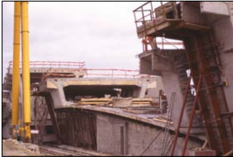
Illustration 60 : Installation de préfabrication des voussoirs
