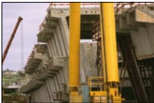
Illustrations 61 et 62 : Stockage des voussoirs préfabriqués
