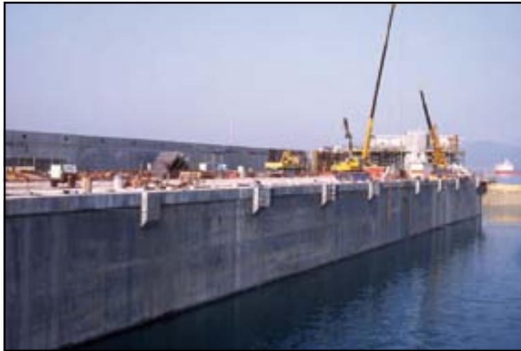
Illustration 107 : Quai flottant en béton
