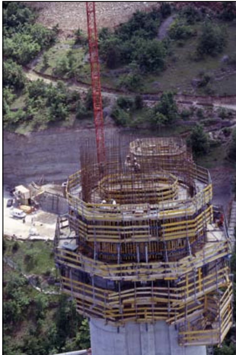
Illustration 4 : Coffrage d'une pile de pont
