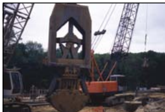
Illustrations 90 et 91 : Parois moulées avec benne suspendue à un câble
