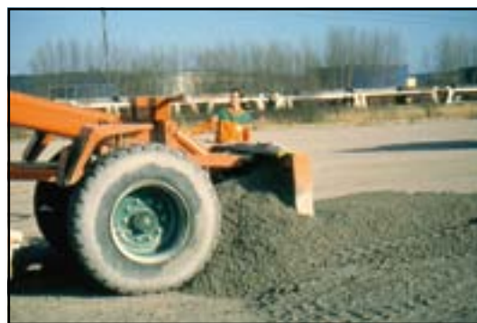
Figure 19 : Nivellement de la grave traitée
