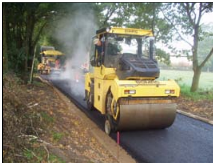
Figure 41 : Compacteur mixte (pneu + cylindre) lourd pour enrobés bitumineux (Source : FAYAT)
