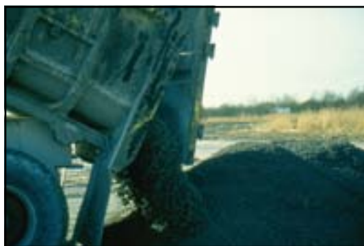
Figure 18 : Déchargement de la grave traitée
