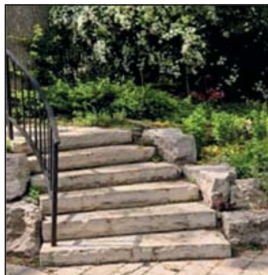
Figure 5 : Escalier calcaire et rampe en aluminium laqué noir
